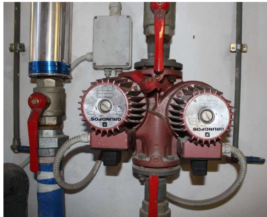
Figura 3.2 Valvola a tre vie ed elettropompa circuito ACS
